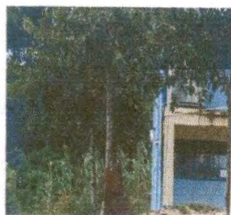
Foto 5: 18.3 Sustrucción de depósito de agua 1700 lt
