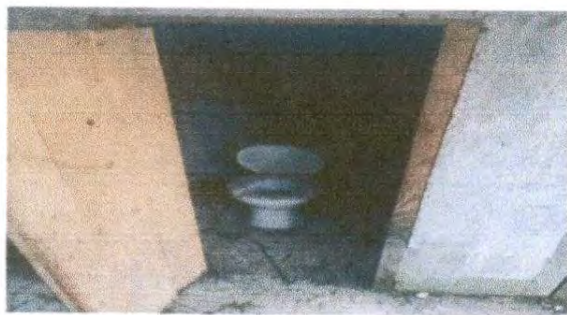
Foto 3: 6.4 Reparación de piso cerámico
