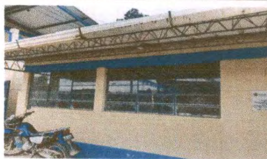
Foto 4: 5.5 Sustitución de balcones de metal
