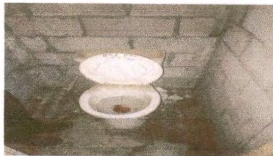
Foto 2: 21.1 Repello en muro
