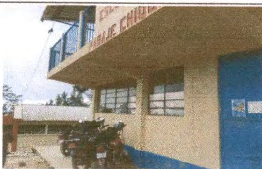
Foto 3: 5.6 Sustitución de balcones de metal
