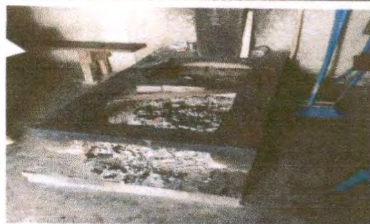
Foto 6: 19.5 Fabricación e instalación de portón de metal de ingreso
