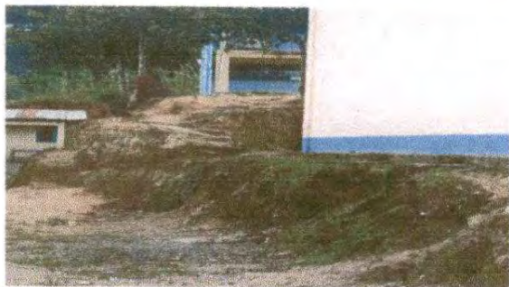
Foto 1: 14.4 Sustrucción de tubería PVC línea principal aguas pluviales
