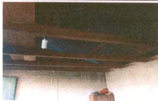
Foto 2: 2.2 Sstitución de estructura de soporte de madera, por metal M2
