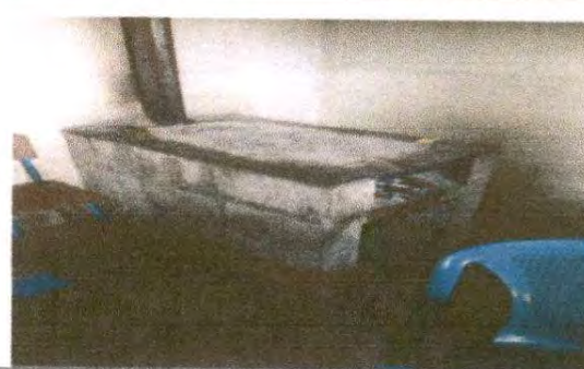
Foto 4: 20.7 Instalación de azulejo en estufa rural
