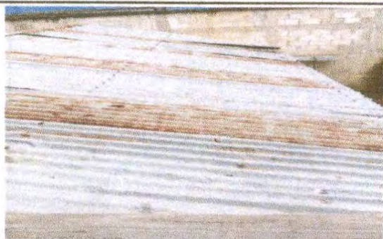
Foto1: 1.1 sustitución de lámina, por lámina troquelada aluzinc calibre 26
